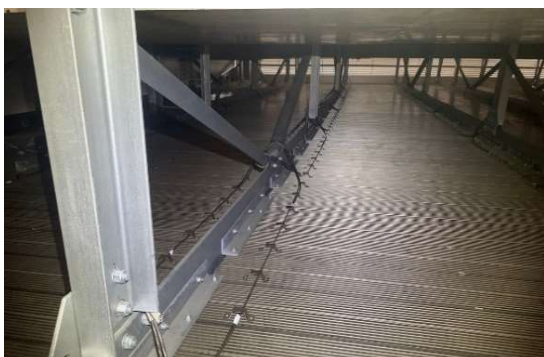
写真 9 箱桁直下の裏面パネル
