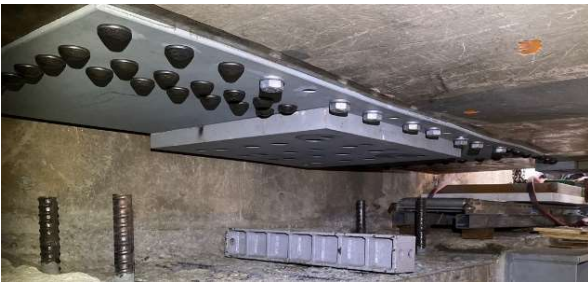
写真 5 厚板補強部材設置完了
