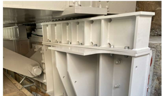
写真 2 段差防止構造
