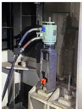
写真 3 ケーブル緩め作業状況
