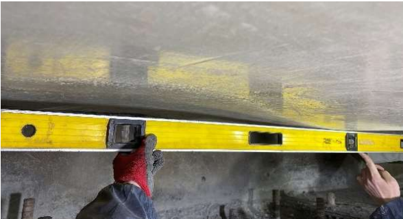
写真 4 箱桁下フランジのゆがみ
