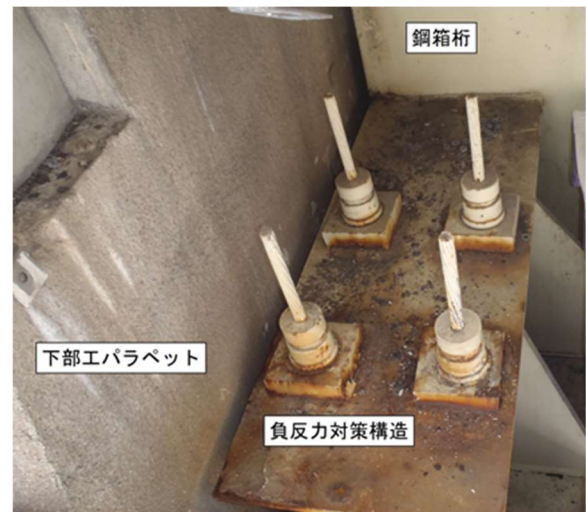
図3 桁端部状況
