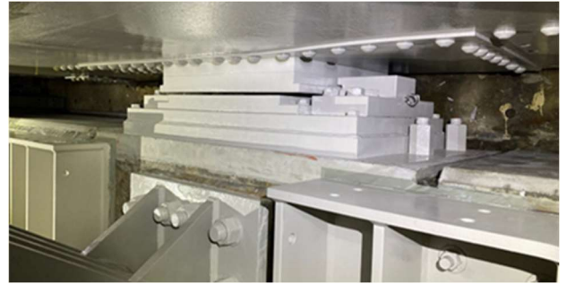
写真 6 支承取替完了
