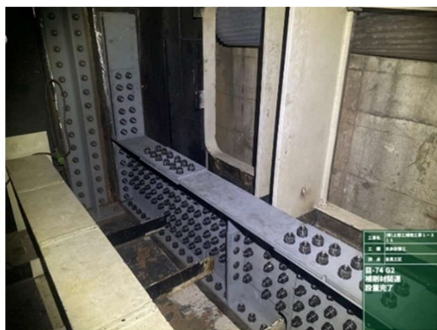
写真1 増設横リブ設置状況
