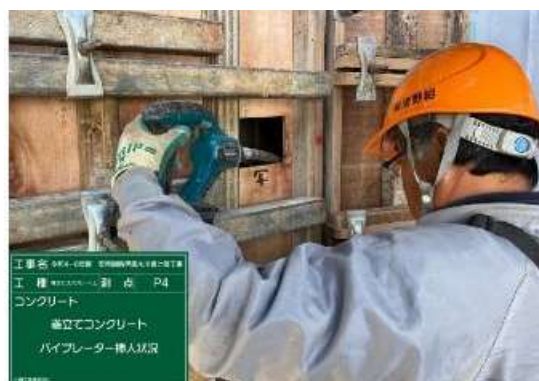
写真 1 コンクリート打設時の締固め
