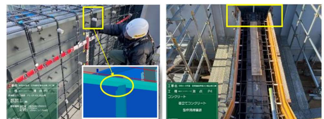
(a) 横桁補剛材の取付け部
