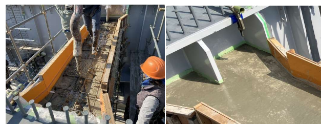
(a) コンクリート打設
