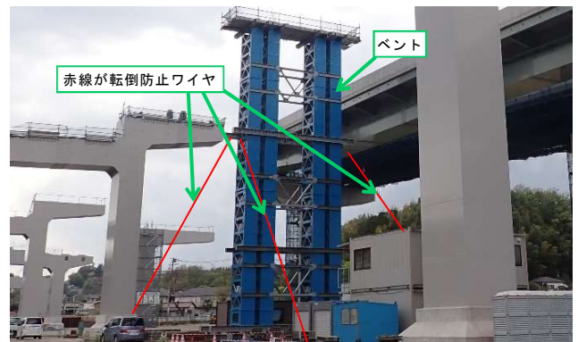
図 7 ベント転倒防止対策ワイヤ
