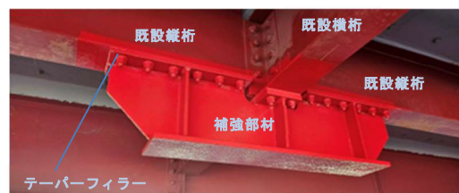
図 3 縦桁き裂補強 全景
