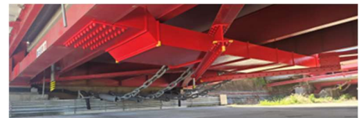
写真 2 落橋防止装置
