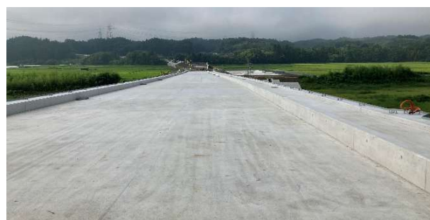
写真 2 完成時床版コンクリート表面
