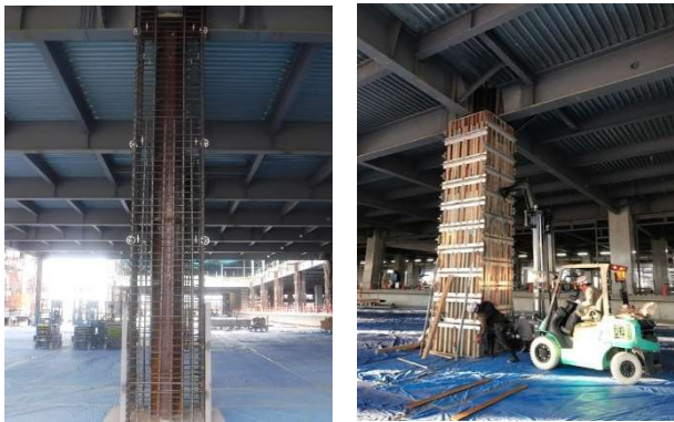
写真3 床コンクリート打設後に配筋(左)・型枠(右)工事
