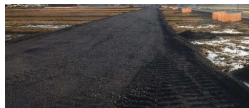
写真 1 製鉄スラグ砕石材を盛土に使用
