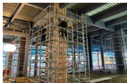
写真 2 従来は鉄骨建方後に SRC 柱工事(他現場)
