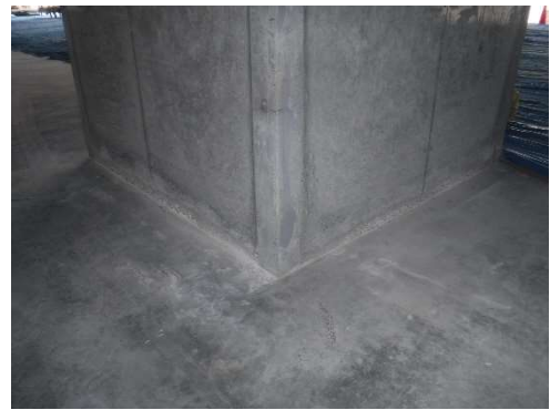
写真4 柱根本部は釘孔補修程度が必要
