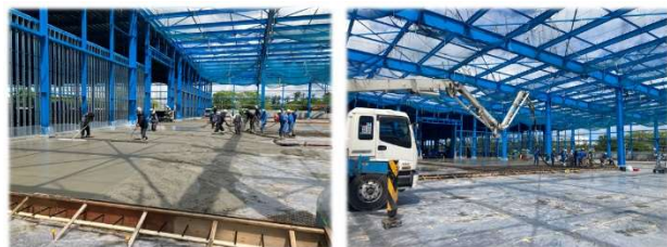
写真 2 土間コンクリート打設状況
