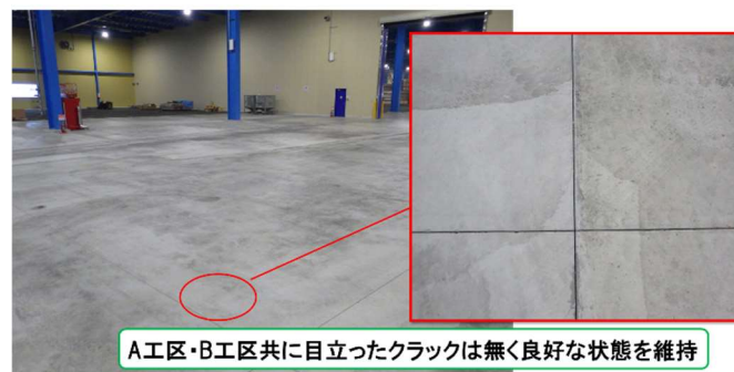
図 6 土間スラブひび割れ抑制経過観察
