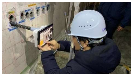
写真2 削孔管理 IoT システム計測状況
