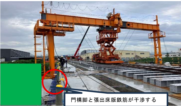
写真 1 門構移動時の干渉
