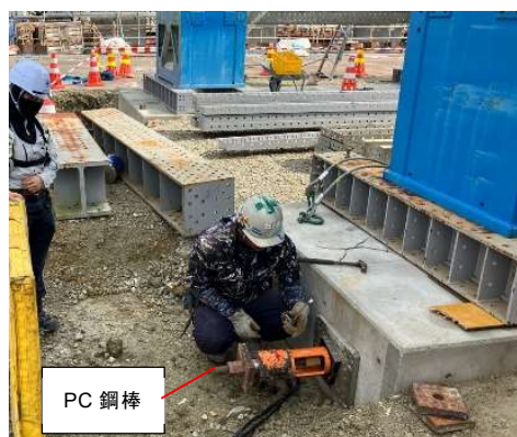
図 5 基礎コンクリート緊張状況
