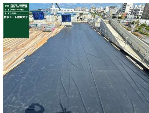
写真 3 防水シート設置
