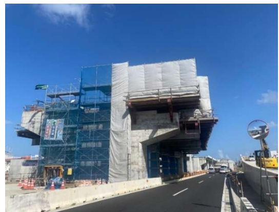
写真 1 支保工組立完了 支保工張出部
