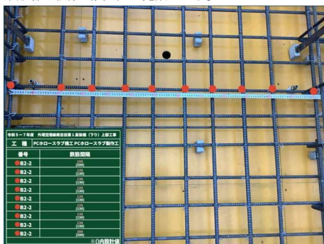
鉄筋出来形管理として工事写真撮影時に、鉄筋出来形管理アプリ「SiteBox 配筋検査」を使用しました。予め管理箇所の鉄筋間隔設計値をアプリ内で作成しておき、現場ではアプリ上で実測値の記入と鉄筋へのマーカーの設置を行い写真撮影（写真 2）します。事務所に持ち帰り「出来形管理クラウド」にデータを取り込むことで出来形管理帳票（図 3）が完成します。
