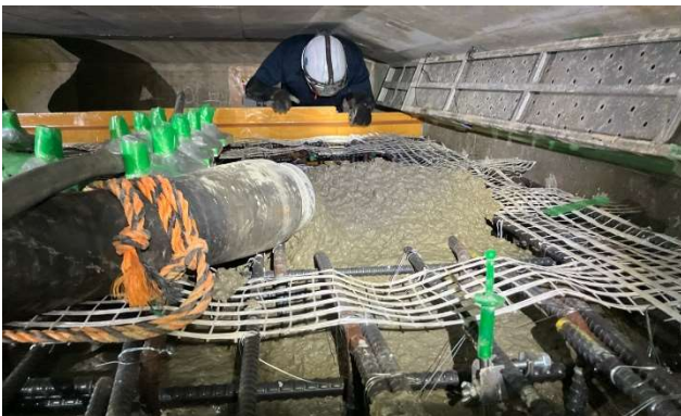
写真1 高流動コンクリート打設状況
