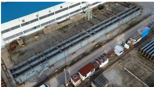
写真 1 工場ヤードにて仮組立て状況
