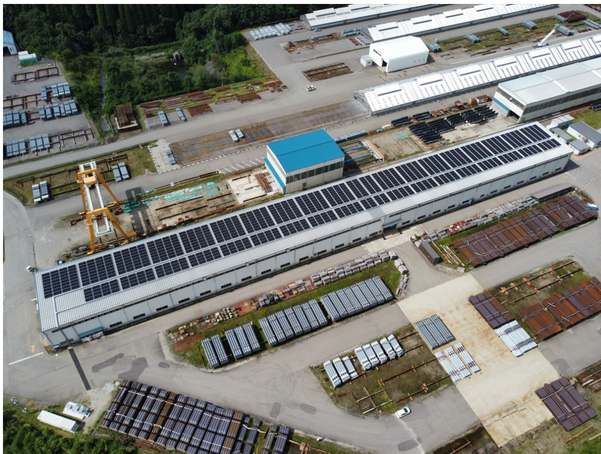
川田工業 安居工場に設置した太陽光パネル
